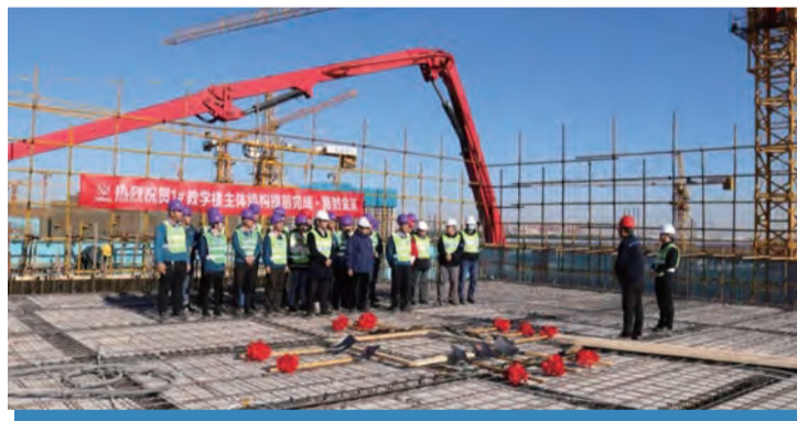
核工业大学天津校区一号教学楼封顶
