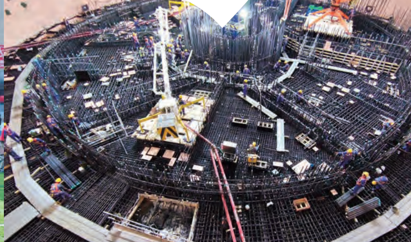
漳州核电1号机组核岛零米板浇筑
