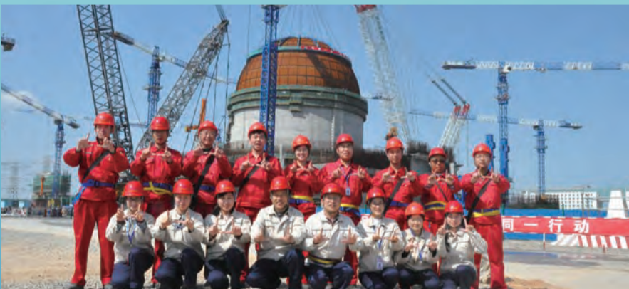
福清核电6号机组穹顶吊装
