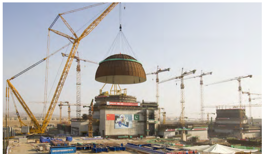
K-2穹顶吊装
