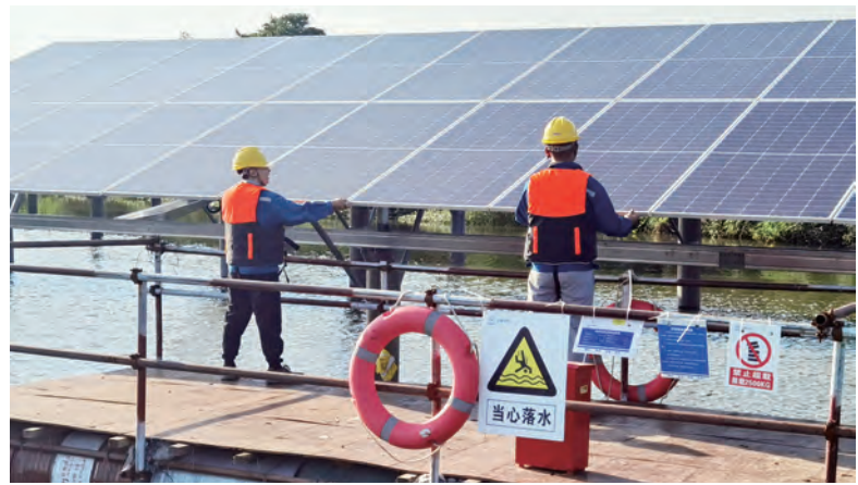
“渔光互补”光伏发电项目建设
