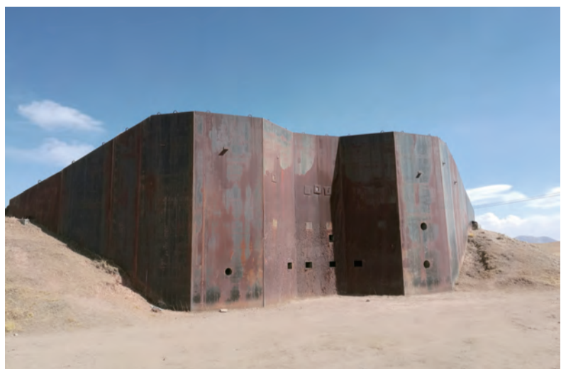
二二一厂爆轰试验观测掩体
