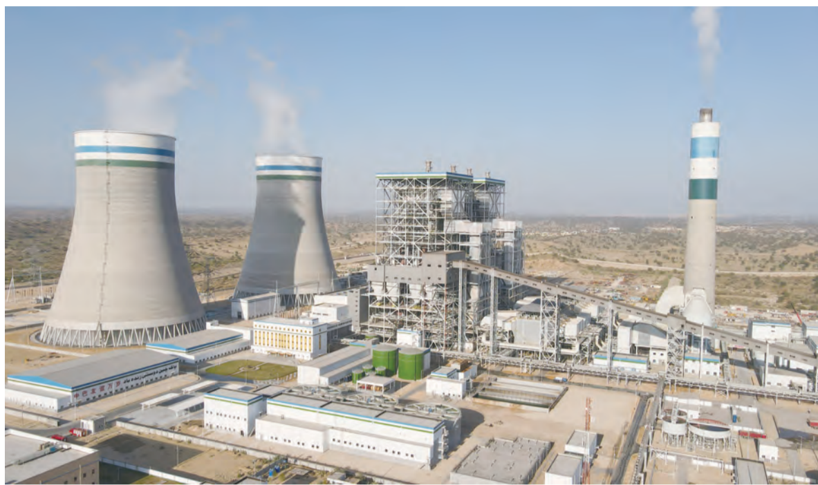
巴基斯坦塔塔尔2x660兆瓦燃煤电站项目
