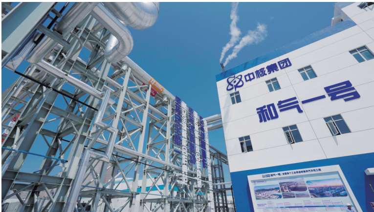
全国首个大规模工业用途核能供热示范工程——“和气一号”
