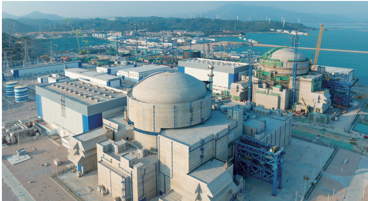
“华龙一号”批量化建设项目漳州核电1号机组商业运行
